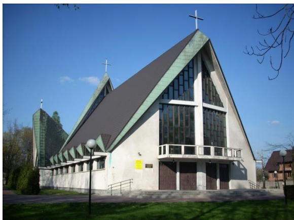
Fot. 1. Elewacja frontowa kościoła pw. Najświętszego Serca Pana Jezusa w Radomsku
