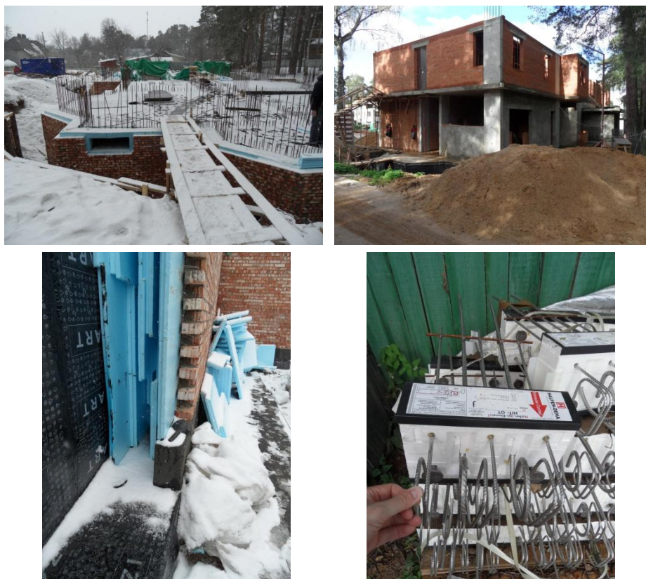
Рис. 8. Фото со строительства объекта (Возведение стен, утепление здания, применяемые в проекте терморазъемы)
