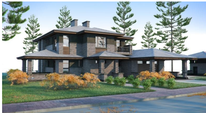
Рис. 4. Индивидуальный жилой дом в коттеджном поселке «РАЙТ ПАРК» в пригороде г. Санкт-Петербурга
