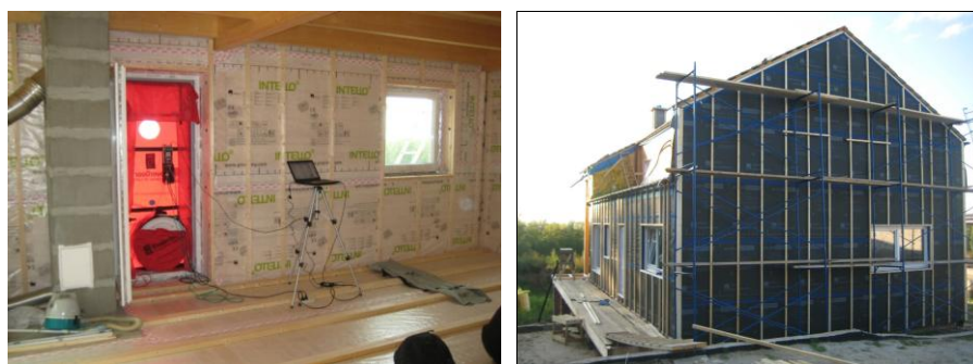
Рис. 6. Фото со строительства объекта (Возведение каркаса, утепление здания, устройство пароизоляции, монтаж окон, проведение BlowerDoor теста, монтаж ветрозащиты)
