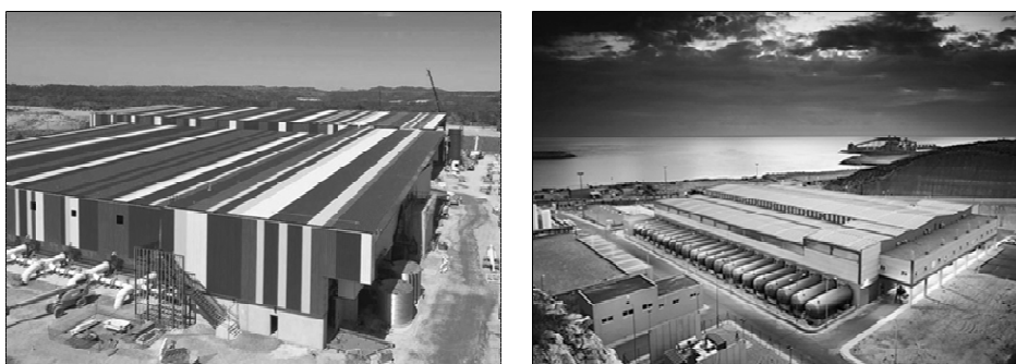
Рис. 2. Примеры обратноосмотических станций по опреснению морской воды
