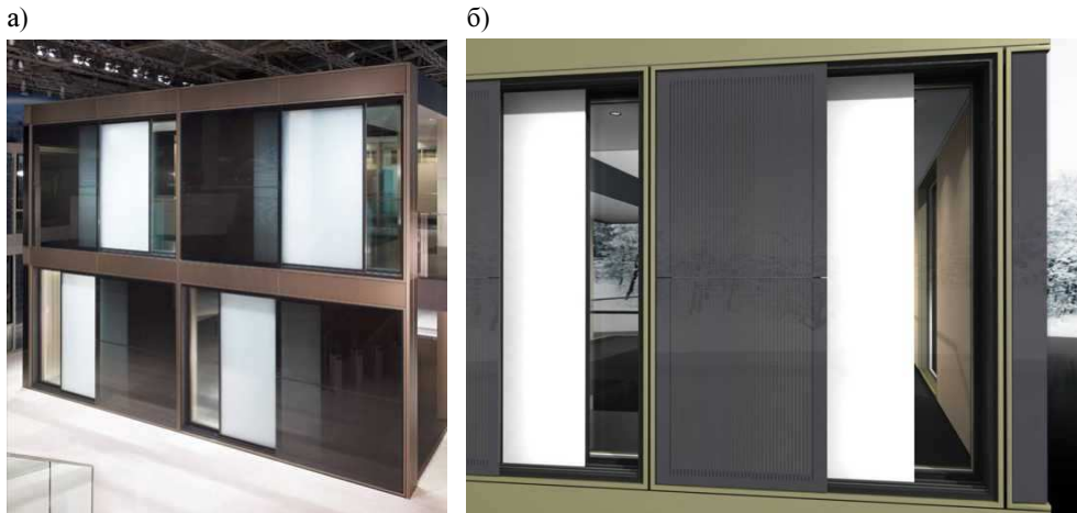
Рис. 3. Внешний вид функциональных слоев (а) и неподвижного фотоэлектрического слоя (б)
