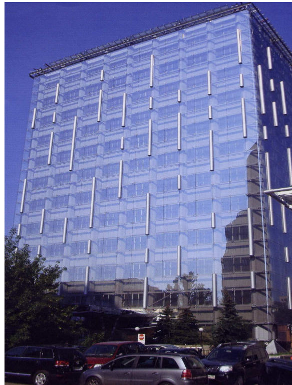
Рис. 7. Новый имидж старого здания. (здание с двойным фасадом - double - skin façade)
