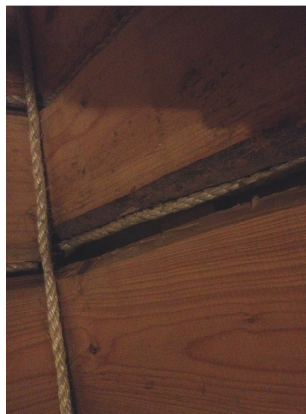
Rys. 4. Szczeliny wewnętrznego deskowania
