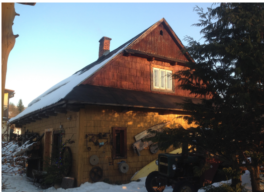
Rys. 1. Widok elewacji północno-zachodniej
