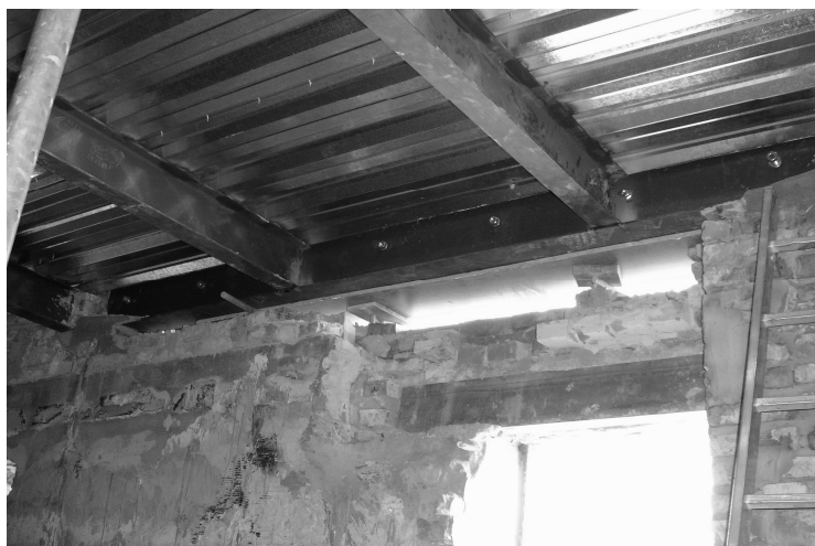
Rys. 2. Widok nadproża podczas wykonywania robót [archiwum autora]
