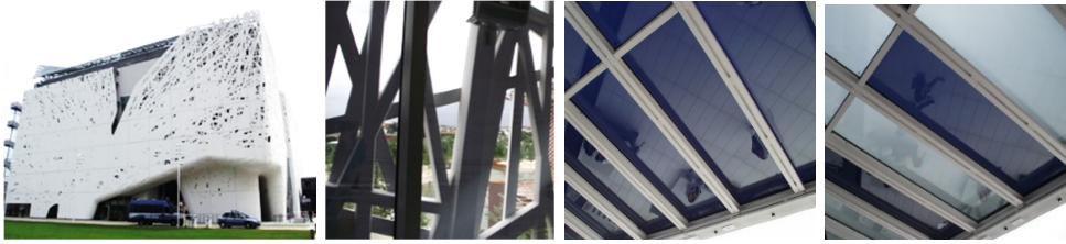
Il. 8. i Il. 9. Zastosowanie materiału budowlanego na elewacji oczyszczającego atmosferę z zanieczyszczeń, a także zmniejszenie powierzchni odbijającej słońce, detal elewacji z płyt betonowych i.active BIODYNAMIC widziane z wnętrza pawilonu; Pawilon Włoski, Wystawa Światowa EXPO, Mediolan, 2015 [fot. A. Gumińska, 2015]. Il. 10. i Il. 11. Technologia SPD Smart Windows zastosowana w Pawilonie Amerykańskim na Wystawie Światowej Expo 2015 w Mediolanie we Włoszech, panele częściowo „otwarte” i „zamknięte” na słońce [fot. A. Gumińska, 2015]
