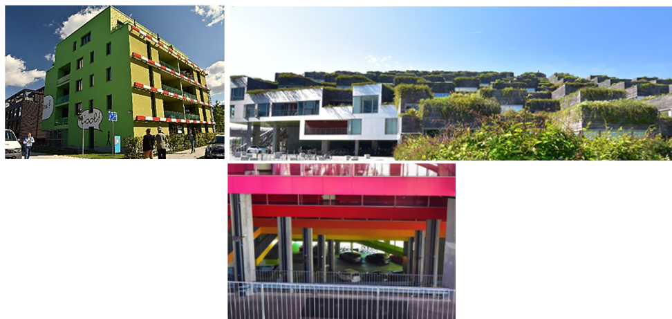
Il. 12. BIQ - Mikroalgi - budynek z fasadą z mikroalgami do wytwarzania energii, kontroli światła i cienia w budynku, Hamburg, IBA, Niemcy; zdjęcie budynku bez paneli z mikroalgami [fot. Gumińska A., 2015]. Il. 13. i Il. 14. Budynek wielorodzinny, Kopenhaga, Dania, PLOT + BIG Architekci, Mountain Dwellings, rezydencjonalna góra 2008. Ogrody tarasowe, wnętrze obiektu z garażami [fot. Gumińska A., 2016]
